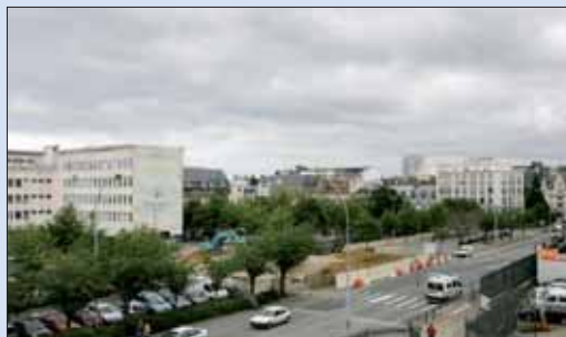
Le terrassement, 1ère phase du chantier du Champ de Mars débutera en octobre.
