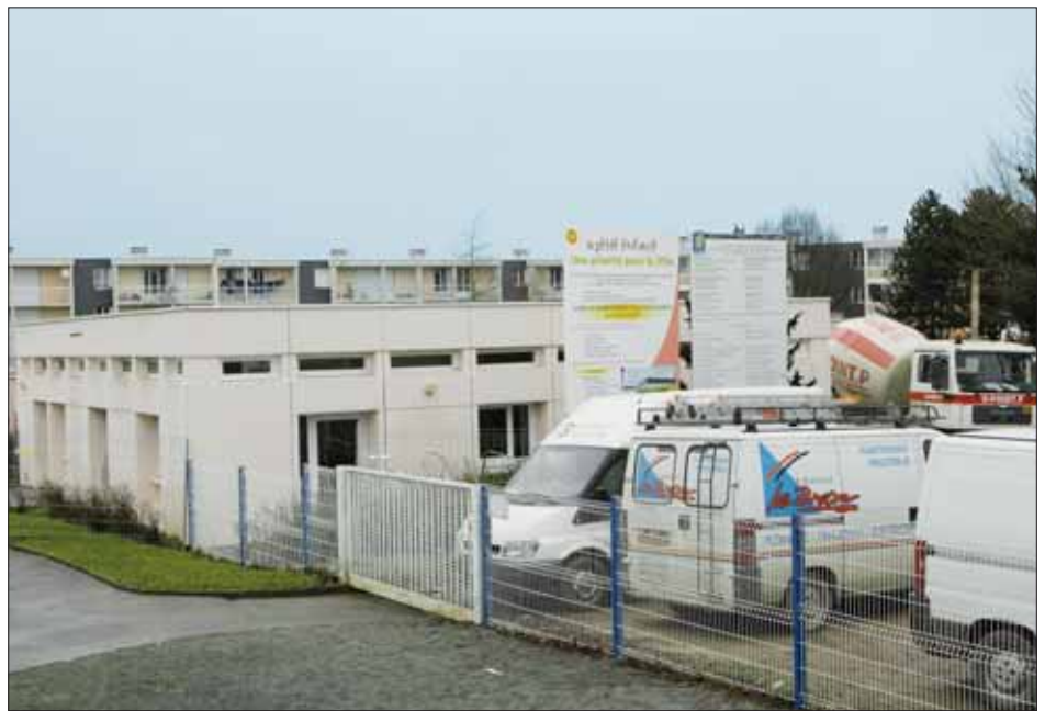
La nouvelle maison du petit enfant de la Croix Saint-Lambert s'intègre dans le projet de rénovation urbaine.
