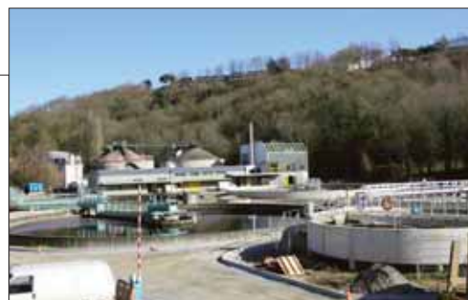
La station d'épuration produit du biogaz (méthane) qui peut chauffer les logements de la Plaine de Balzac.
