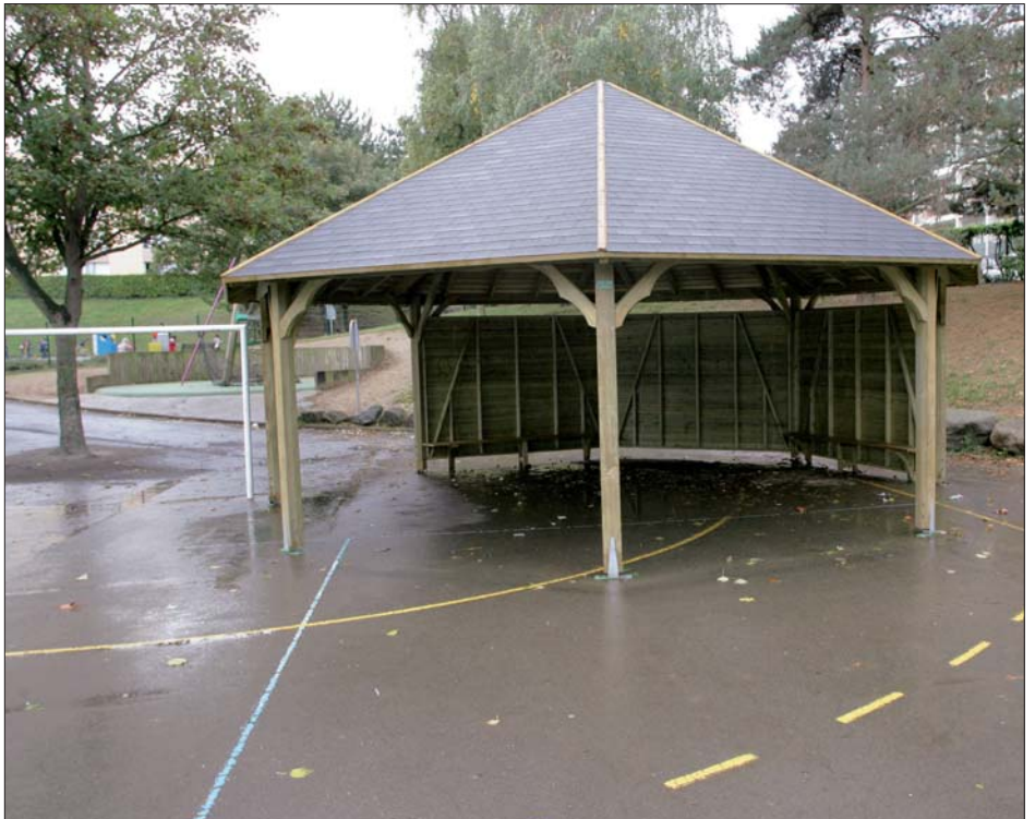
Un nouveau préau pour l'école de la Brèche aux Cornes.
