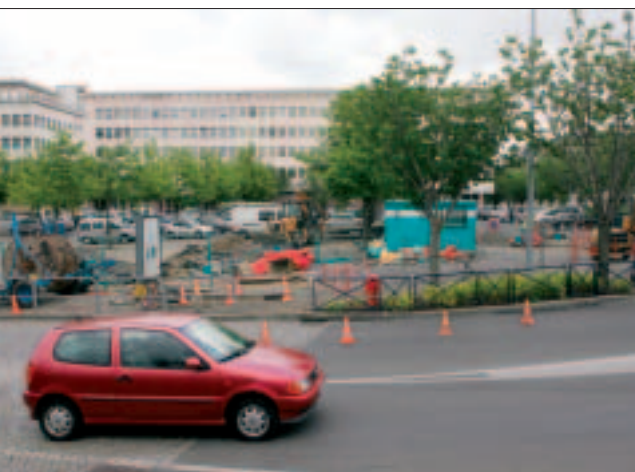
Des premiers travaux préparatoires ont eu lieu en juin.
