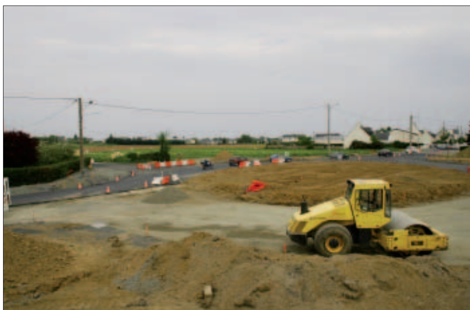
Les Villages offrent un bon potentiel de développement. Ici, la rocade en travaux, devant un terrain qui accueillera une quarantaine de nouveaux logements.
