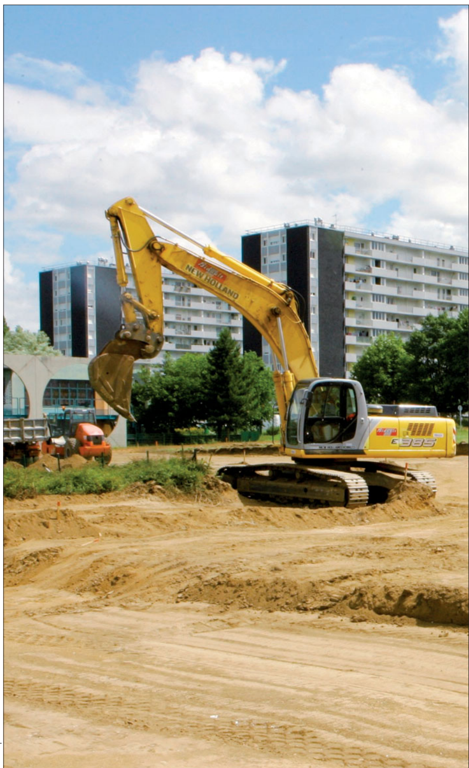
Les travaux ont débuté sur la plaine de Balzac où Saint-Brieuc Agglomération construira une piscine et Cabri Habitat 26 logements.
